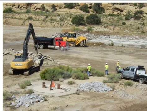
チャーチロック・ウラン鉱山 縦坑 No.1 付近の除染作業。 2009 年 8 月 26 日(水) 撮影 筆者
