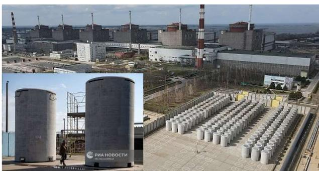
図2 キャスクと使用済み核燃料乾式貯蔵施設
